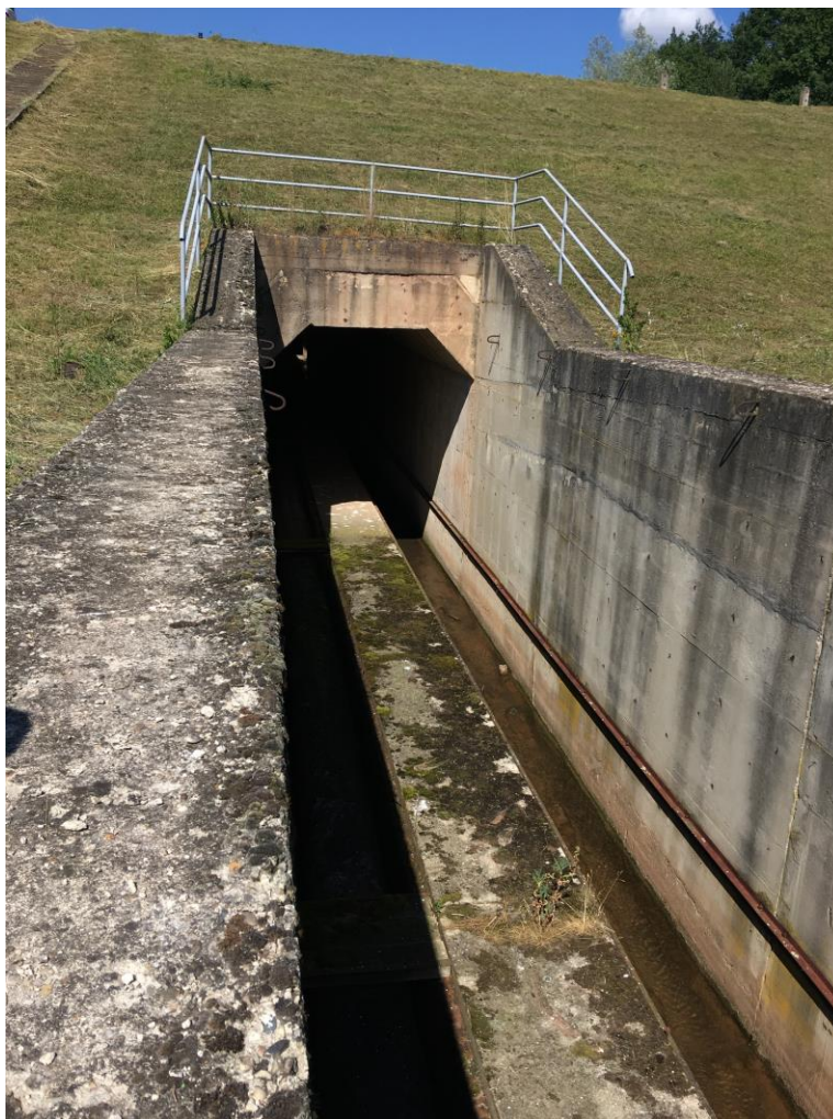
Foto č.5: Vyústění odpadní chodby a stávající ocelové zábradlí.
