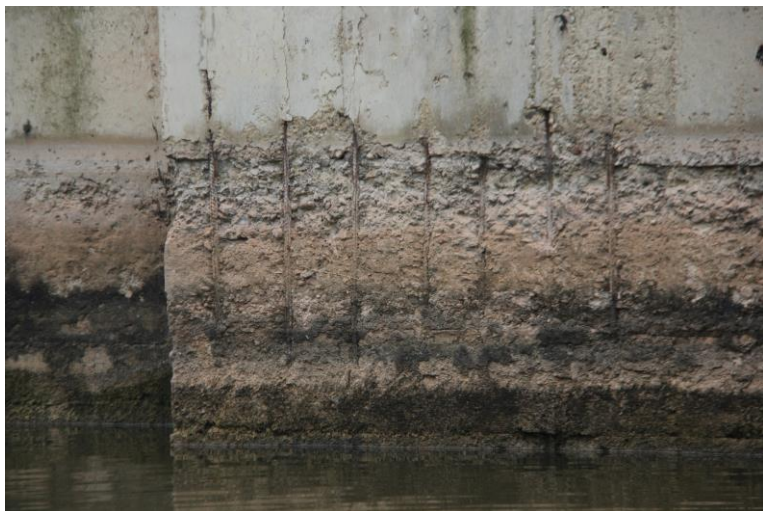
Foto č. 4: Pohled na degradovaný beton věžového objektu.
