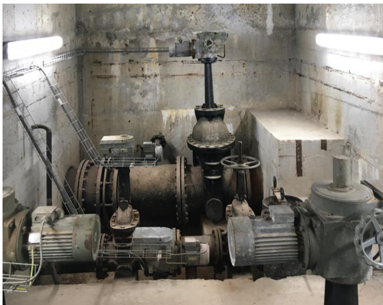
Foto č.8: Pohled na uzavěry spodních výpustí.
